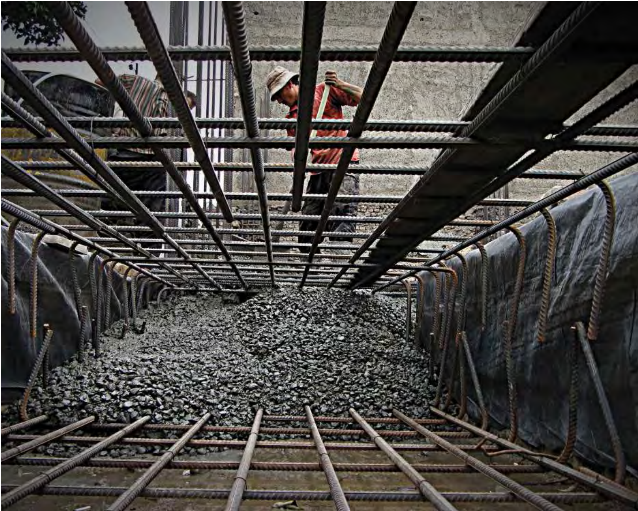
پر کردن فونداسیون ساختمان توسط کارگر ساختمانی در گرگان. عکس: محمد مهدی امیا
